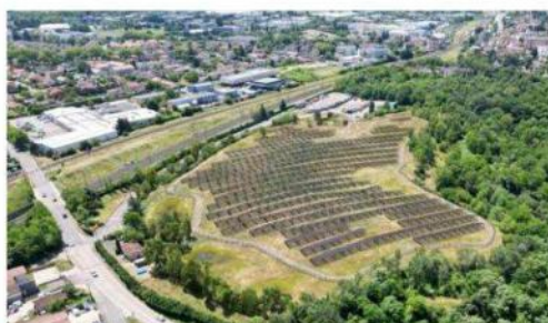
Une version révisée du projet de parc solaire à Rillieux-la-Pape. Photo Fournie Par Cve
