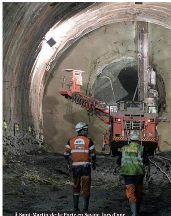
À Saint-Martin-de-la-Porte en Savoie, lors d'une visite de chantier en 2019 : ici le creusement est effectué de façon traditionnelle à l'explosif. Photo Maxime Jegat
